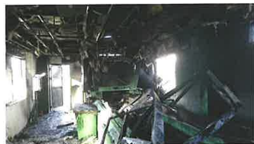
▲リチウムイオン電池の発火が原因で、リサイクル工場の建屋・設備が焼けてしまった事例
