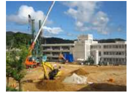
校舎改築2期工事
